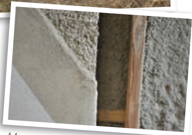
Matériaux de construction apparents (ouate de cellulose, blocs chaux-chanvre)
